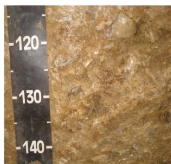
Contact entre les colluvions caillouto-graveleuses (Dca) et les marnes argileuses sous-jacentes (Mca).
